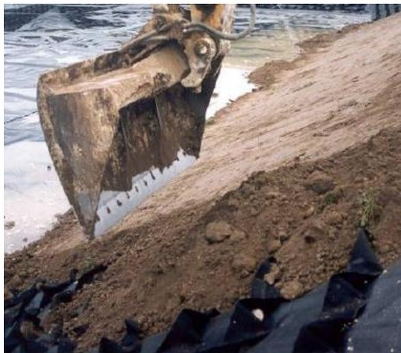
Figure 11. Mise en œuvre de la terre sur le teracro
