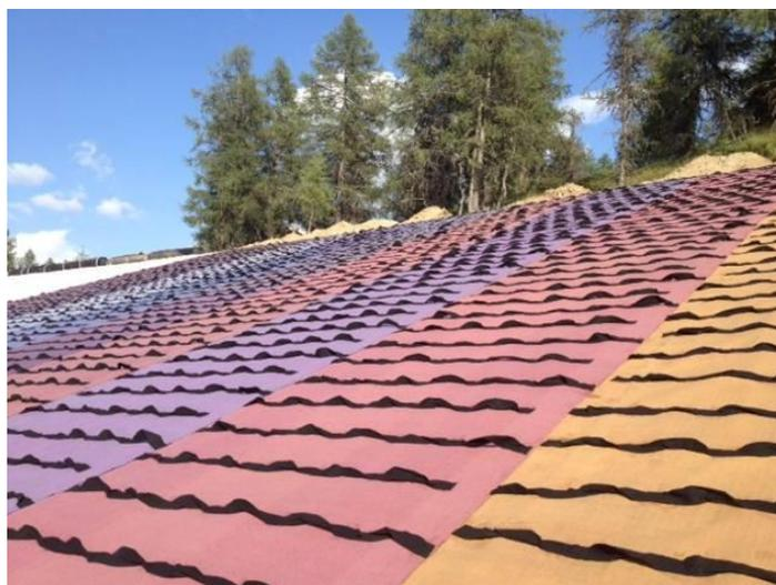
Figure 6. Principe du géocomposite anti-érosion proposé
