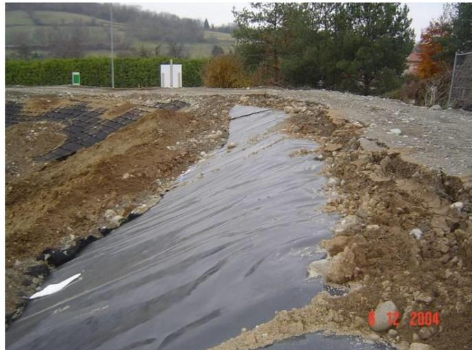
Figure 4. Un accroche terre insuffisamment renforcé peut se rompre sous le poids de la couche de matériaux de couverture
