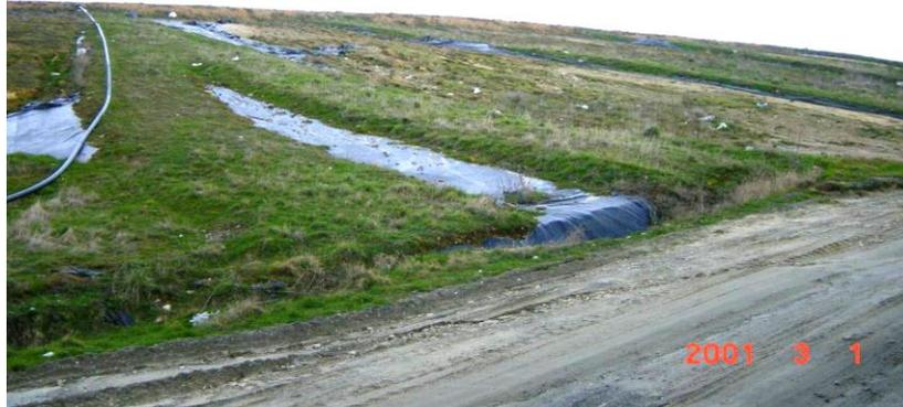
Figure 5. Glissement des matériaux sur le talus étanché, en absence de système de drainage
