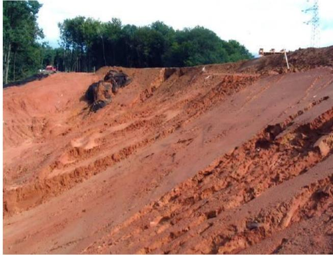
Figure 3. L'absence de relief ou d'autre solution anti-érosion conduit à une érosion des talus
