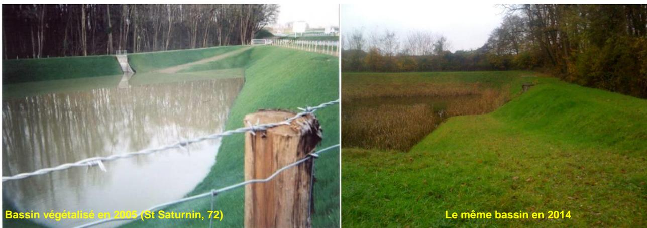
Figure 8 et 9. Durabilité de la solution développée
