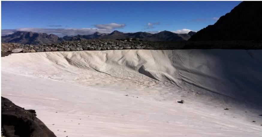
Figure 1. Aspiration de la géomembrane sous l'effet du vent
